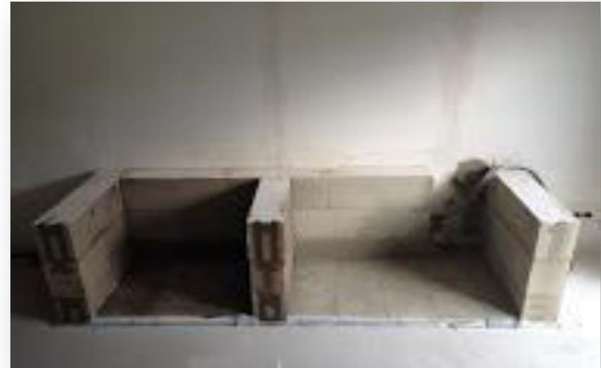
Der Unterbau, bestehend aus gemauerten Gasbetonsteinen und einer Holzbodenplatte (Tischlerplatte) wurde direkt auf die Betonsole gesetzt.
