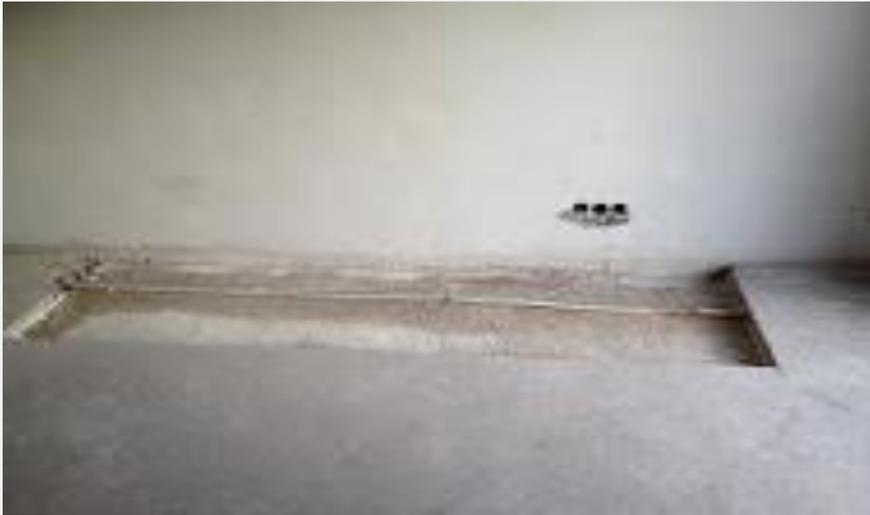
Fangen wir mit dem Unterbau an. Das Haus wurde ohne Keller gebaut und statische Bedenken fielen so fast aus, dass lediglich der Estrich und die Dämmung unter dem geplanten Aquarium entfernt wurde.
