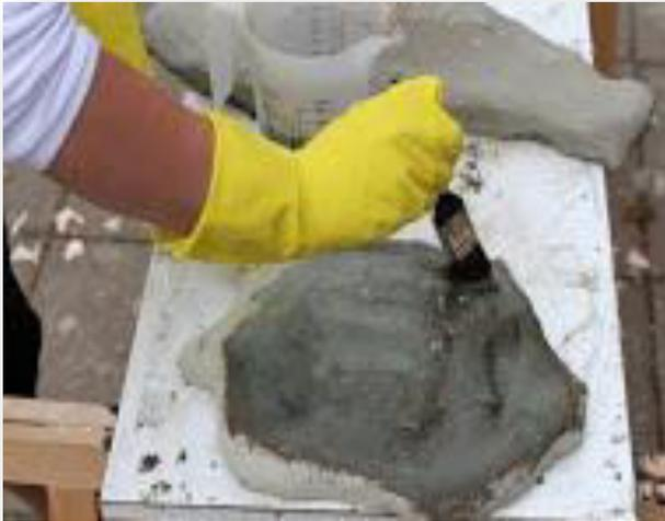
Nach der letzten Schicht, die aus Dichtschlämme besteht, haben wir Quarzsand auf die noch frische Oberfläche gestreut, so sollte ein möglichst natürliches Aussehen hergestellt werden.
