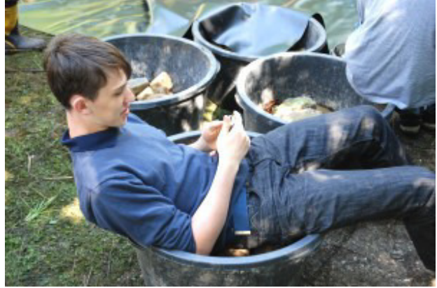
Die Folie ist verlegt, da wird man sich doch eine Handy-Pause gönnen dürfen und wenn es kein bequemeres Plätzchen gibt „setzt“ man sich einfach auf die Steine, bevor sie verlegt sind.
