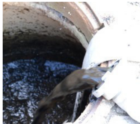
Auch der Schlamm, der sich im Laufe der Zeit angesammelt hat wird entfernt
